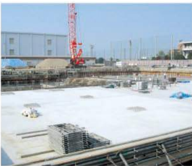
土台工事が進む新図書館等の建設地
